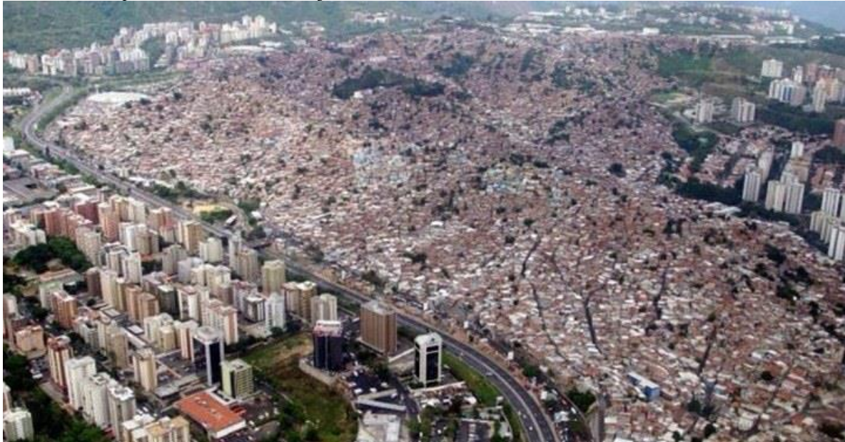
Figura 2. Vista parcial del sector de estudio (fracción del área informal y formal de la ciudad dividida por la Av. Francisco Fajardo) los otros asentamientos además de Petare )
