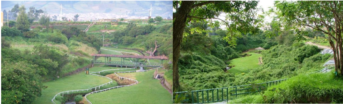
Figura 4.41 Recuperación integral de quebradas El Carmen y Ortega
