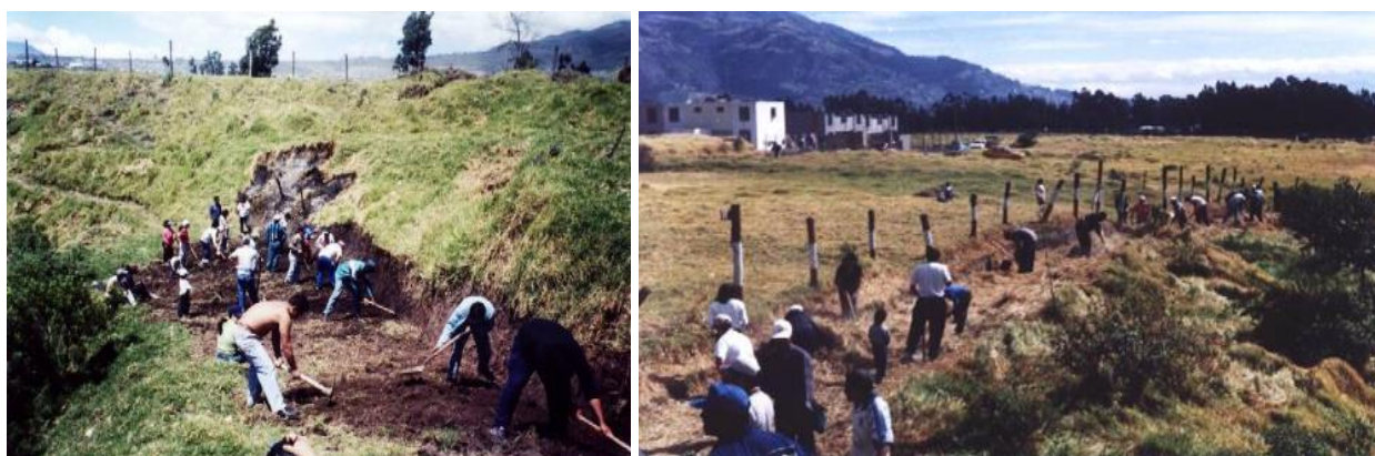
Figura 4.19 Mingas comunitarias en las quebradas del barrio
