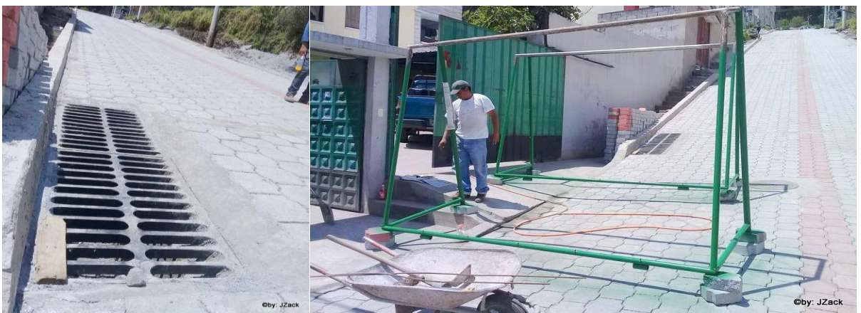
Figura 4.51 Adoquinados y mantenimiento de arcos de fútbol
