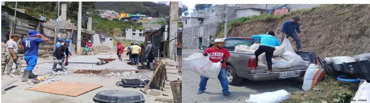
Figura 4.34 Mega mingas obras de alcantarillado y taludes
