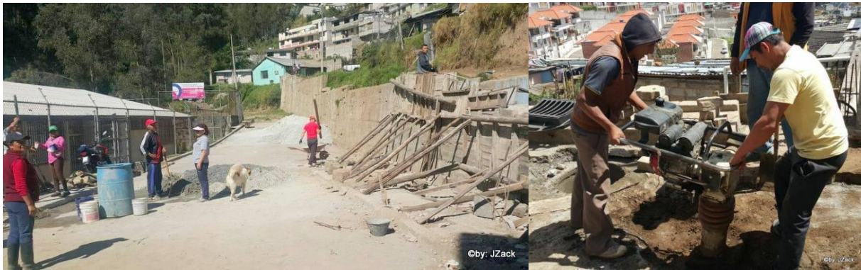
Figura 4.35 Mega mingas muro de contención y nivelación de calles
