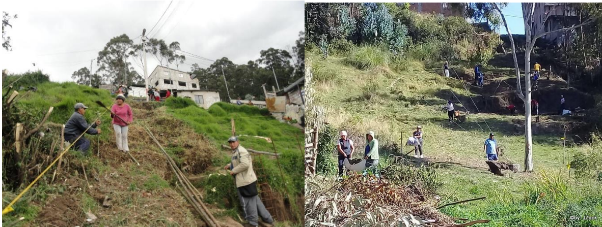
Figura 4.31 Minga de infraestructura de escalinatas
