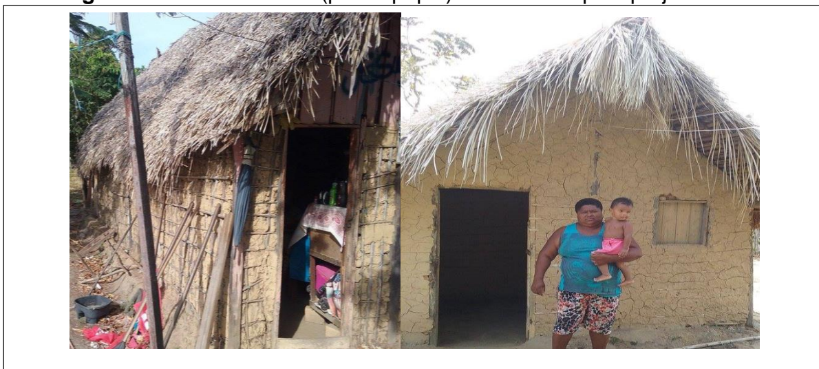
Figura 2- Casas de Barro (pau-a-pique) substituídas pelo projeto.
