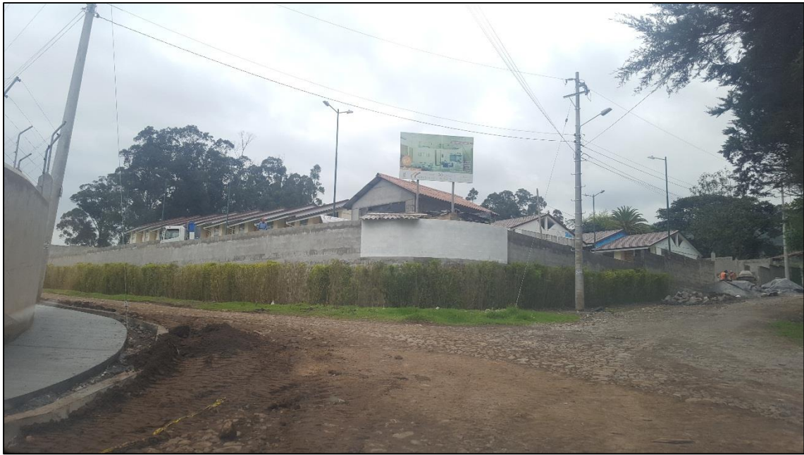
Foto 3. Urbanización en construcción, barrio Pedregal de Miranda, sector norte
