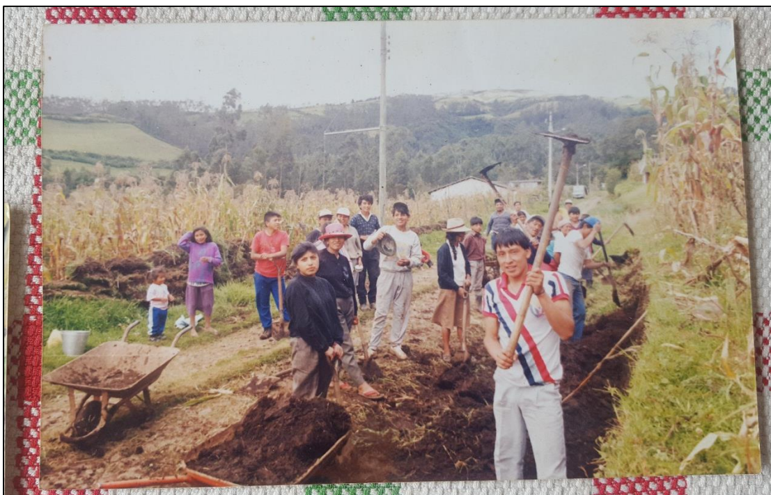
Foto 11. Fotografía antigua de minga de ampliación de vía barrio La Vaquería
