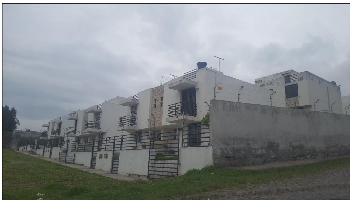
Foto 2. Lotizaciones, barrio Pedregal de Miranda, sector norte
