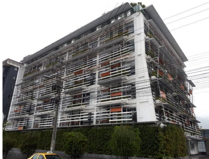
Foto 4.1. Edificio en altura dentro del barrio Floresta
