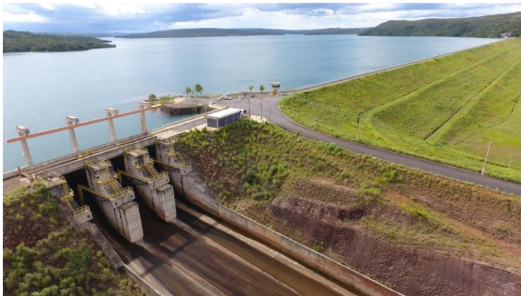
Figura 10: Usina Hidrelétrica Corumbá IV
