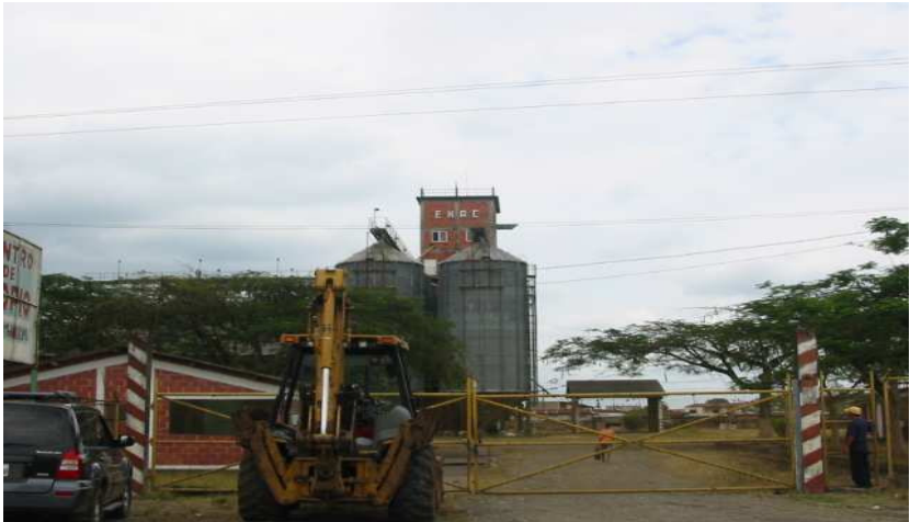
Centro de acopio Empresa Nacional de Comercialización ENAC
