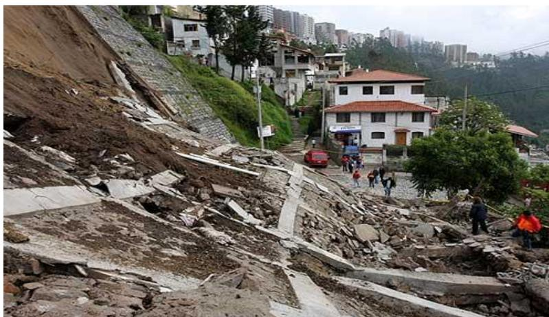
**Foto N° 25** - jornal “El Comercio” dia 30 de março 2009; caderno 2. Muro de contenção com 40m comprimento por 24m altura cai e fecha o Guápulo.
