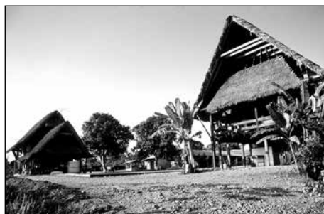
Imagen 51b. Edificio principal de Latinreco (laboratorio y alojamiento)
