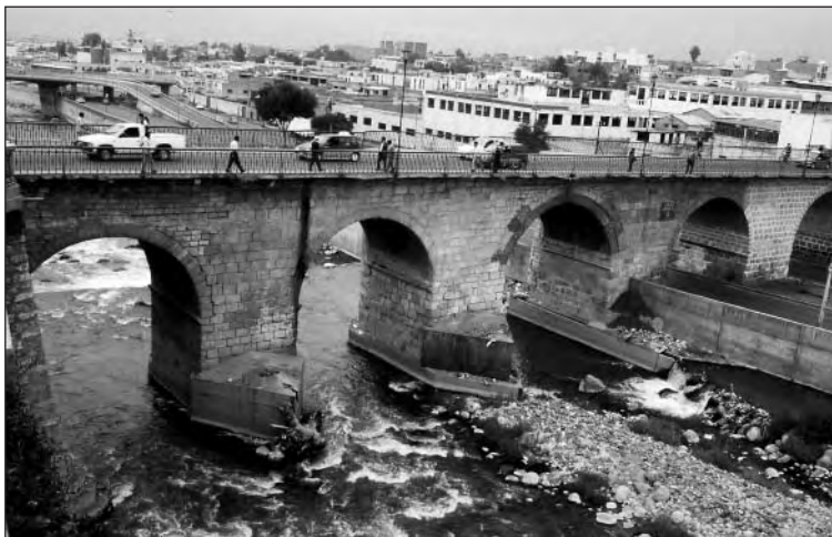
El Puente Bolognesi
