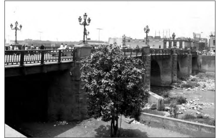
El Puente de Piedra
