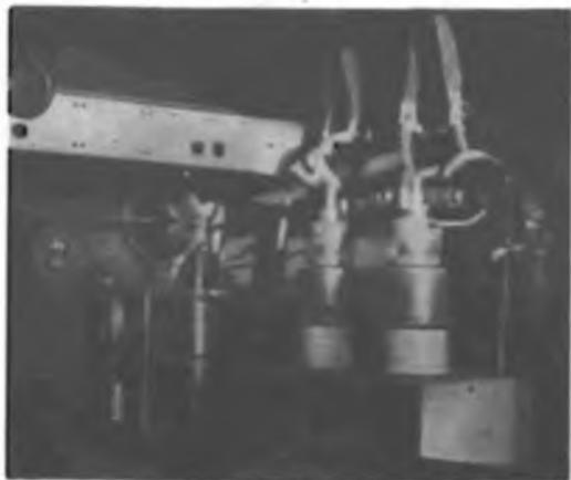
Válvula de Lee Forest basada en los tres elementos: rejilla, filamento y placa; conocida como tródo o tubo de vacío, es el que hace que los impulsos eléctricos se traduzcan en audibles.
