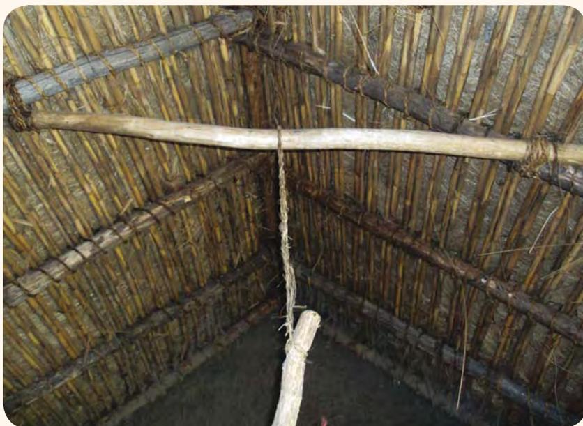
**7)** En la parte intermedia del techo, a 2,5 m del largo de la choza y a unos 0,5 m sobre la base del techo (vigas horizontales) se coloca la sexta viga de 3 m de largo aproximadamente, sujetándola en los extremos a los chaguarqueros, y llegando a formar un A intermedia, con el fin de reforzar la seguridad de la cubierta.
