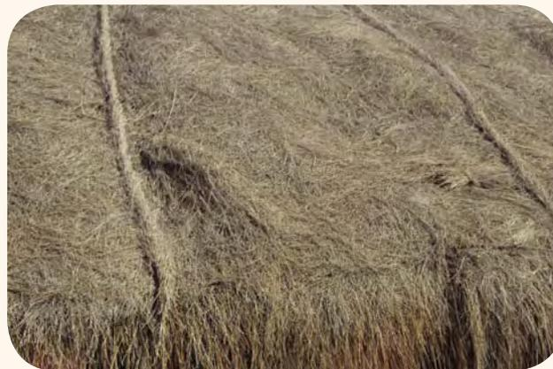
**10)** Al final del cobijamiento se realiza el turse de paja, obteniendo sogas o trenzas gruesas de paja, que se colocan sobre el cobijamiento para evitar que la paja sea levantada con el viento.
