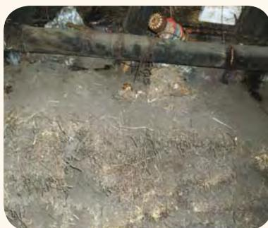
**3)** La excavación permite formar muros o paredes de suelo duro, que son complementadas y niveladas en su parte superior con champas grandes de 0,40 x 0,40 y 0,50 m, y con piedras de tamaño mediano.
