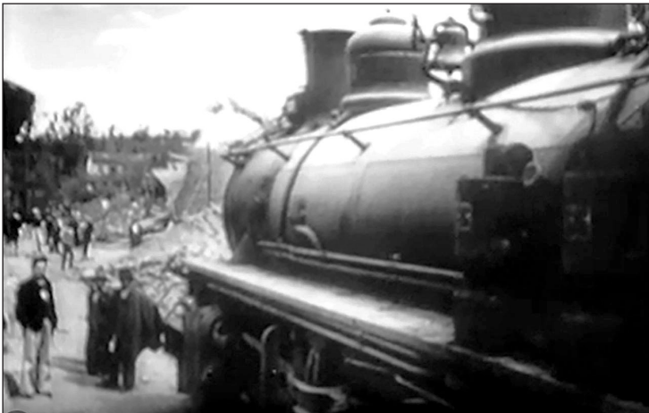
Figura 3.1. Daños en el ferrocarril a causa del terremoto
