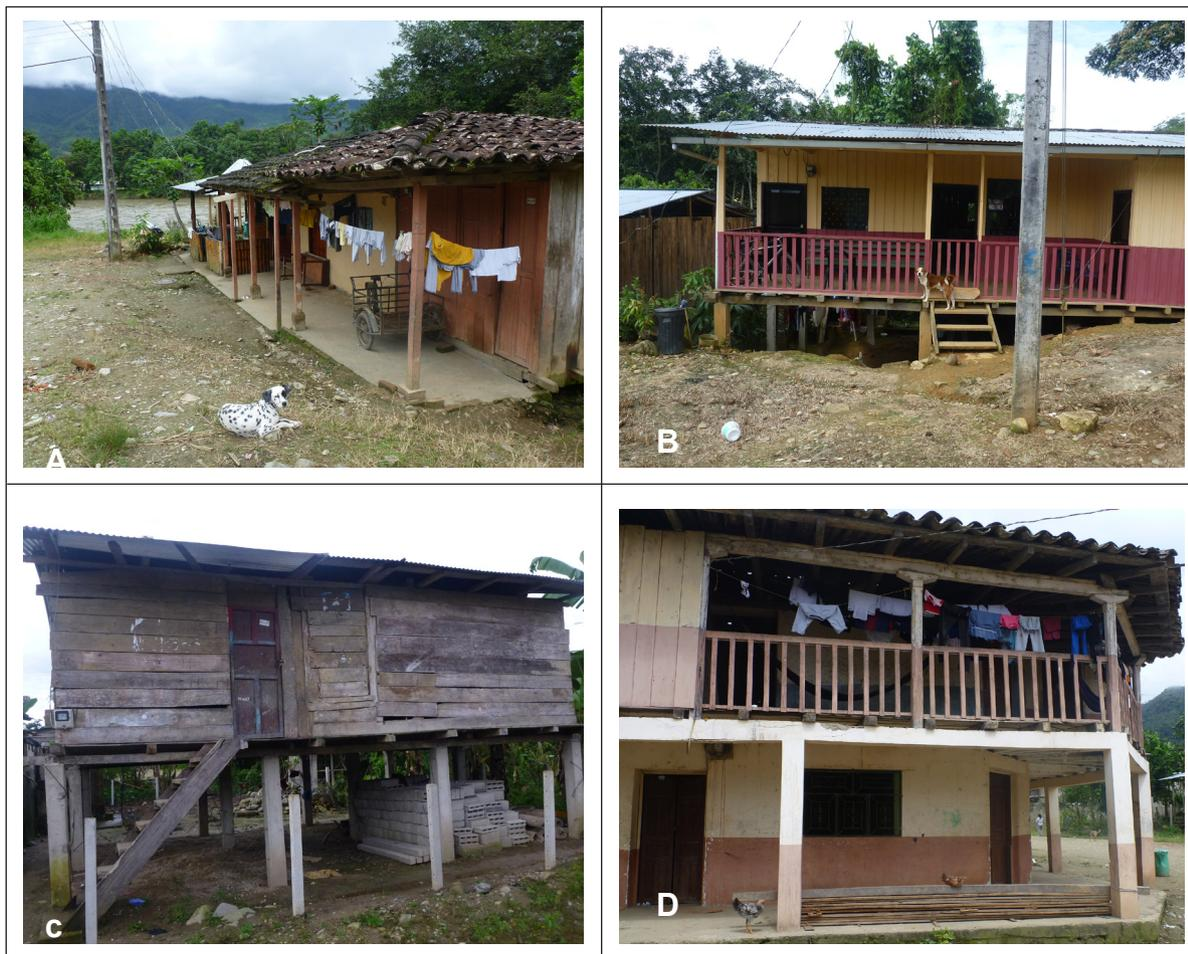
Figura 6. Cuatro tipos generales de vivienda en las áreas de estudio. (a) Casa de madera de un piso sin pilares. (b) Casa de madera de un piso con los pilares. (c) Casas altas de madera de un piso con pilares Construcciones mixtas (d) con techos de hoja del hierro acanalado.
