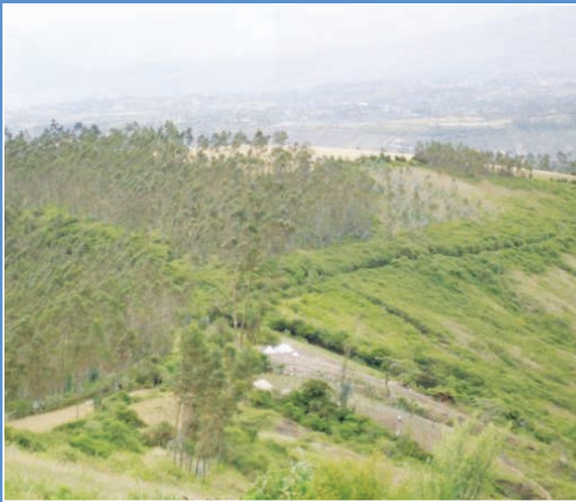
Fotografía N°1 Recorrido de la acequia desde el Tablón
