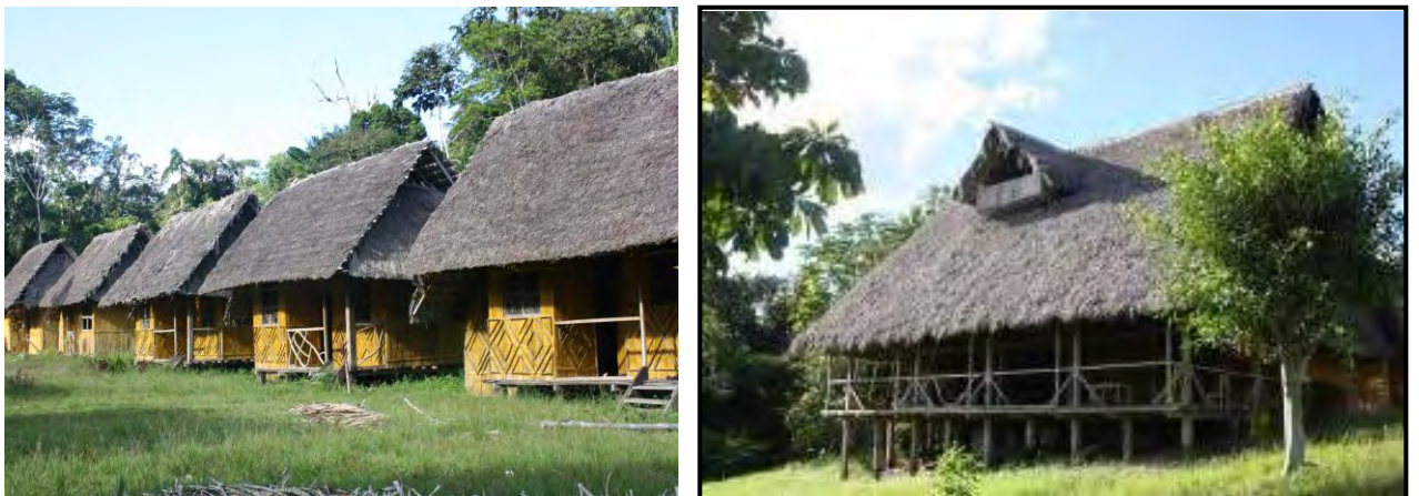
Foto 20 y 21: Infraestructura proyecto “Ruta del Caimán”, comunidad Samona
