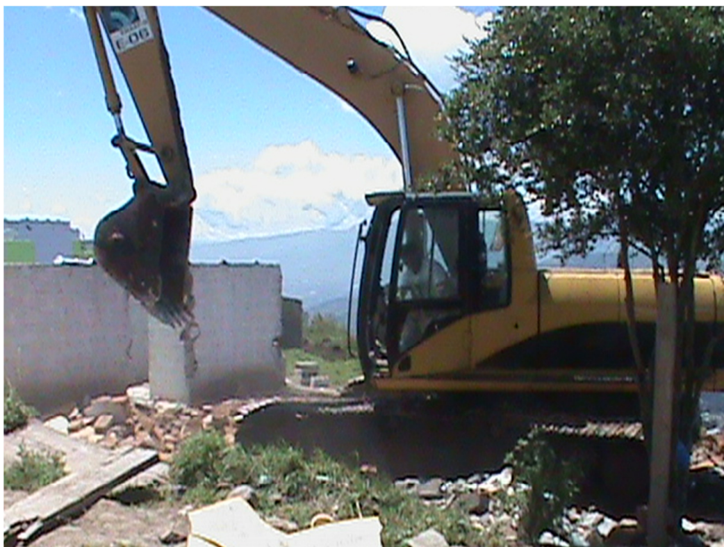
Derrocamiento de viviendas en el Barrio La Forestal
