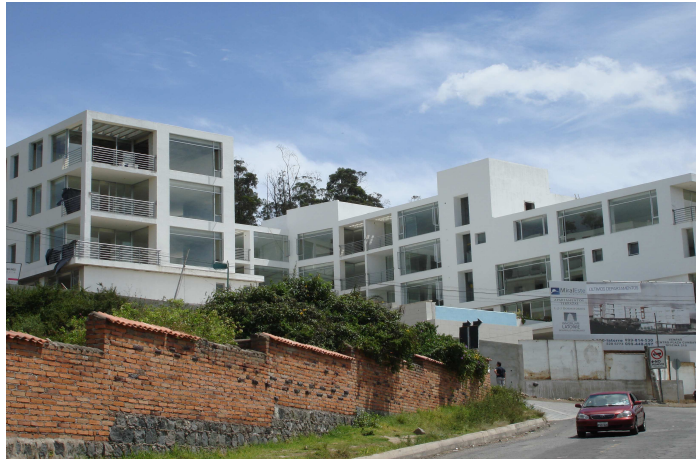
Foto: Edificio de departamentos en construcción
