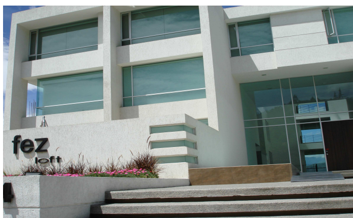
Foto: Edificio de departamentos tipo “loft”
