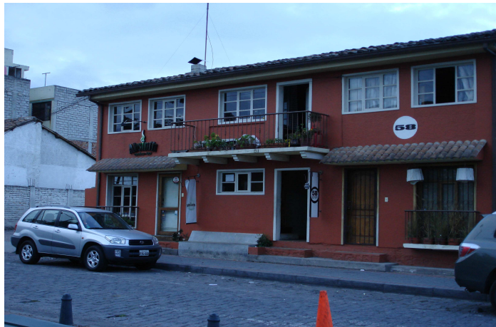
Foto: Edificio remodelado en el Parque Central de Cumbayá
