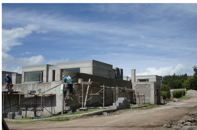
Foto: Un conjunto habitacional en construcción
