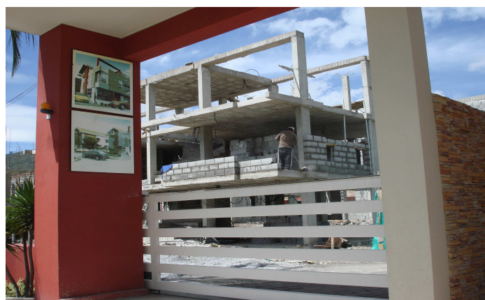
Foto: Conjunto “Tais” en la zona de Limonar en construcción
