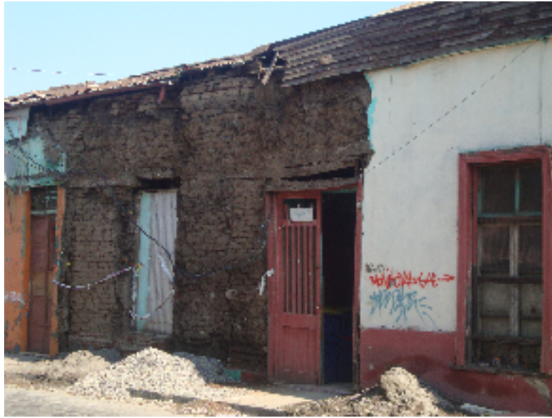
Visita al barrio Yungay 27.06.2010: Viviendas dañadas
