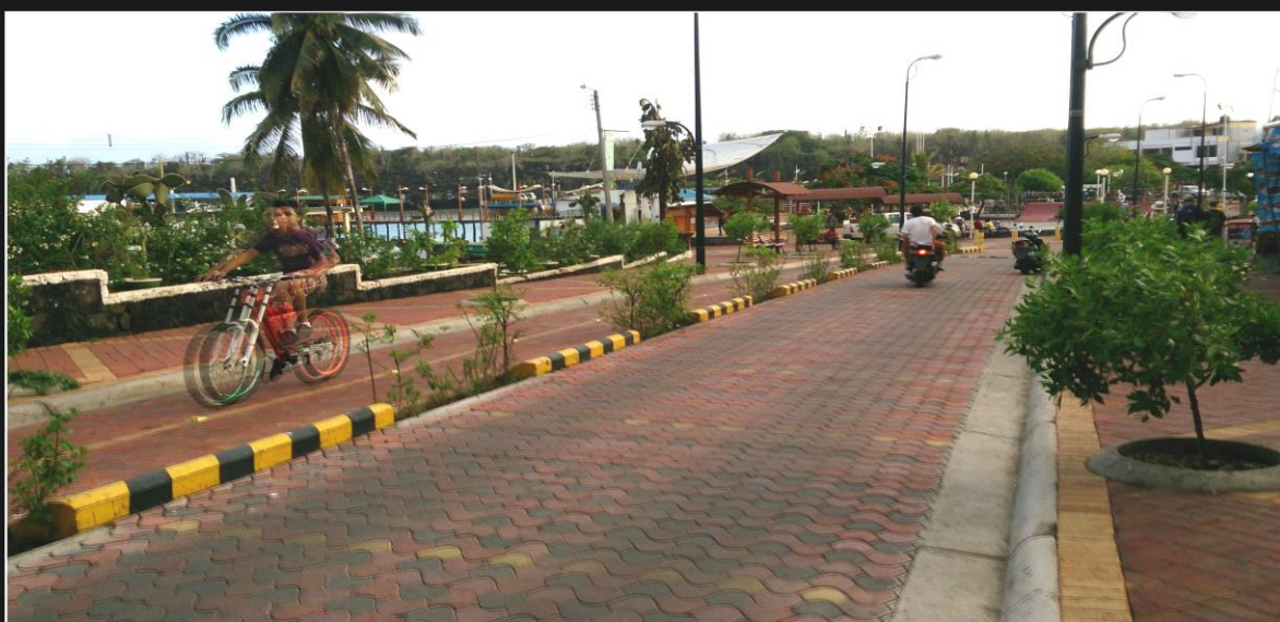
Avenida Charles Darwin (ciclovía separada)
