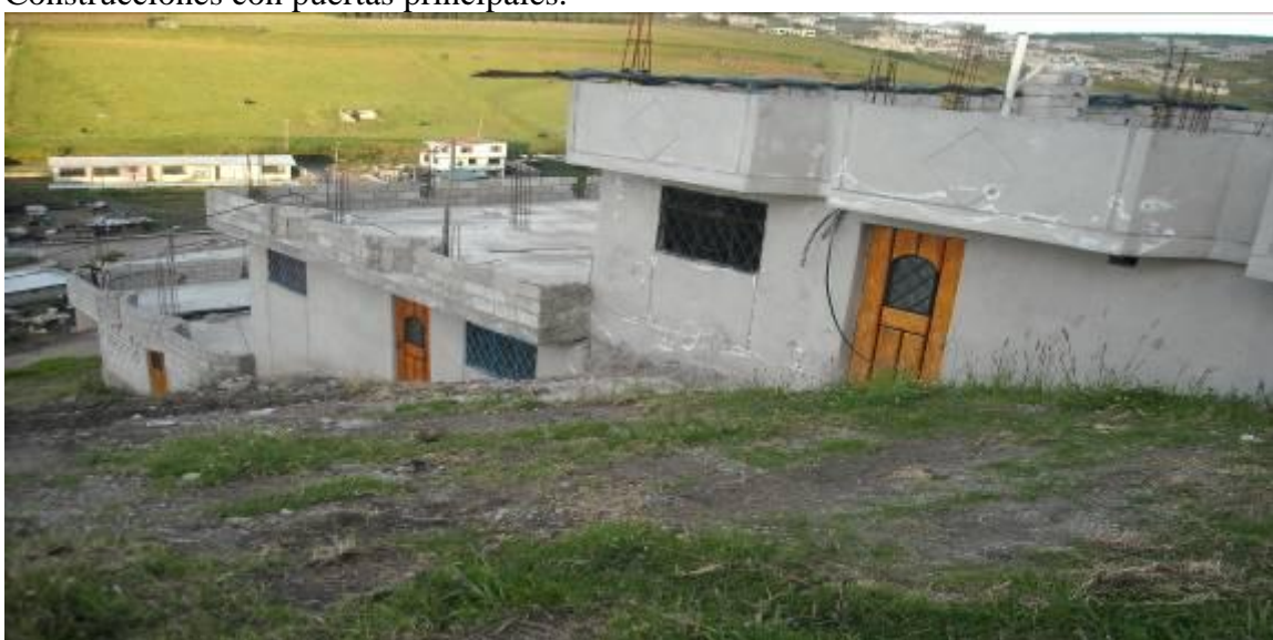
Anexo, fotografía 13: Construcciones con puertas principales.
