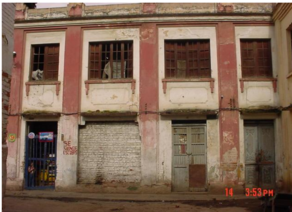
Autor: Alcaldía Municipal de Pasto, Deterioro físico patrimonio arquitectónico
