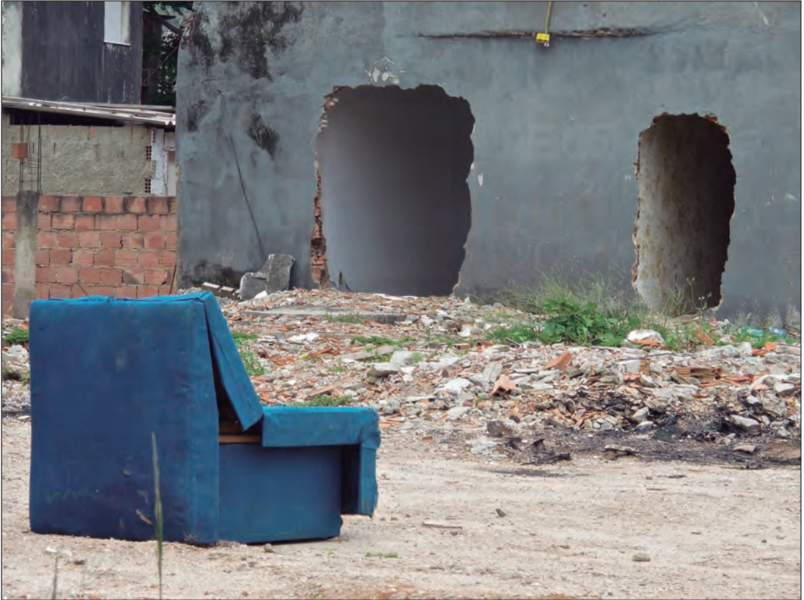
Observar el pasado. En Vila Autódromo permanecen los restos de una ciudad autoconstruida que fue considerada un obstáculo para la construcción de la infraestructura olímpica.
