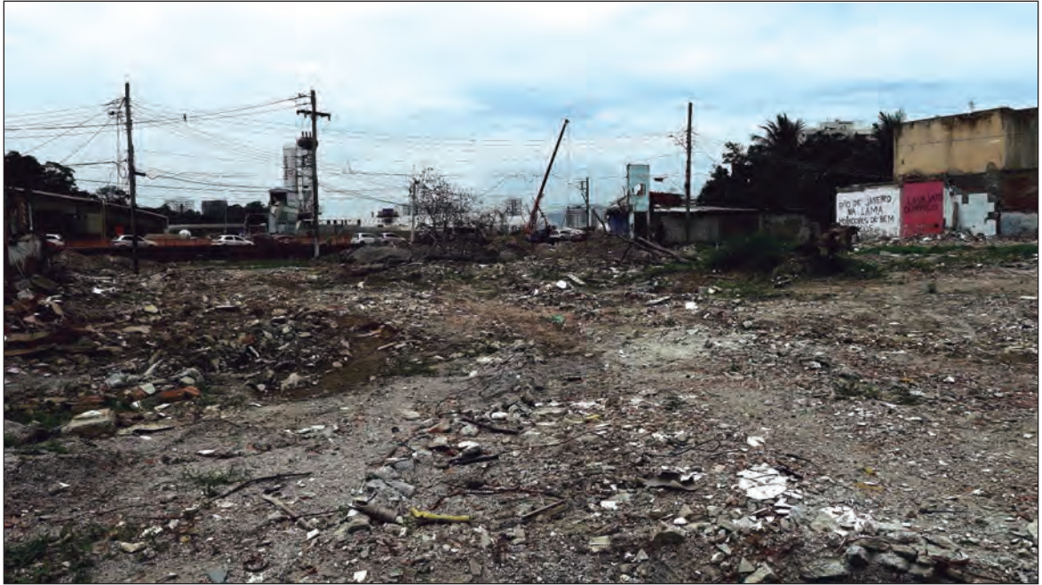
Vila Autódromo. En diciembre de 2015, pocas viviendas quedaban en pie de las más de 450 que había antes de que comenzara la construcción del Parque Olímpico en 2012.
