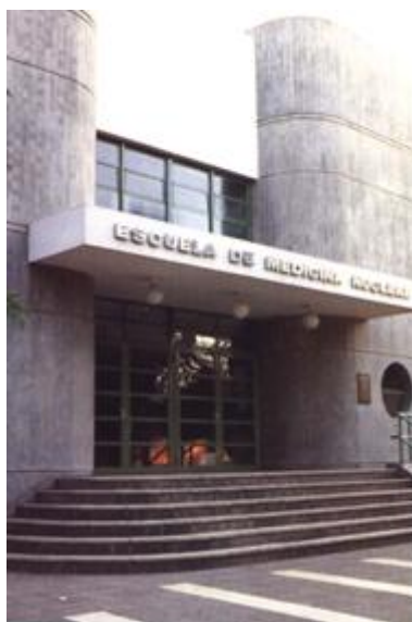
Figura 21: Frente del Edificio de la Escuela de Medicina, FU.ES.MEN. - Pcia. de Mendoza
