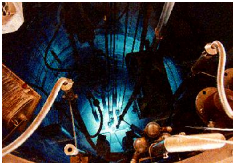
Figura 17: Iluminación producida por la radiación beta (efecto cerenkov) en el RA-3.
