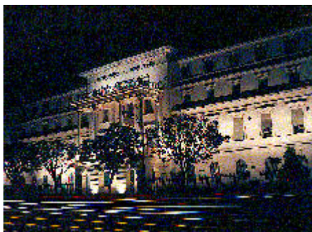
Figura 15: Frente de la Sede Central de la Comisión Nacional Av. del Libertador 8250 - Ciudad de Buenos Aires
