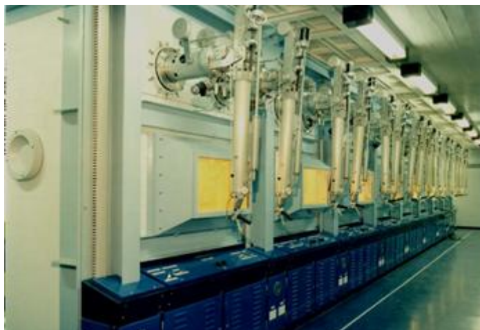
Figura 20: Celdas para manipular material muy radiactivo Centro Atómico Ezeiza - Pcia. de Buenos Aires
