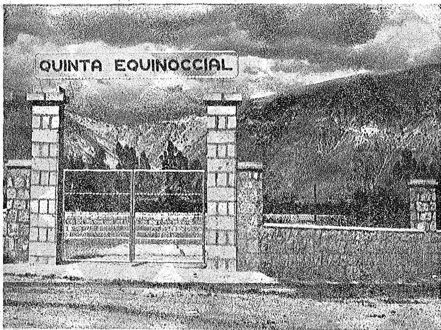
Entrada esquinera a la "Quinta Equinoccial". Construcción de piedra y cemento, realizada en 1951.
