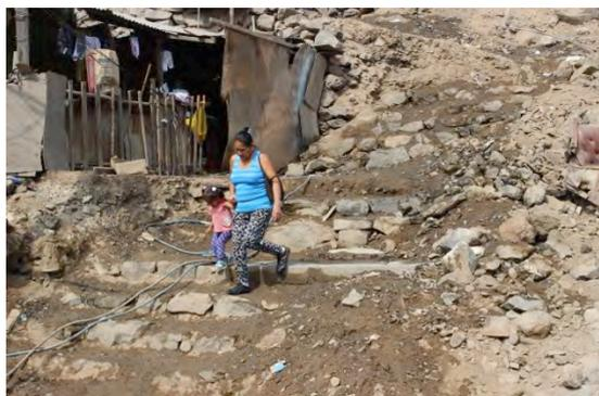
Ilustración 3.28 Escalera en mal estado construida por la comunidad
