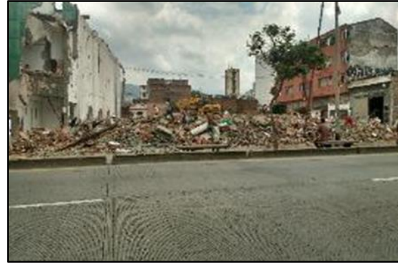
Foto 8. Demolición viviendas barrio el Calvario, calle 13. Registro recolectado en campo
