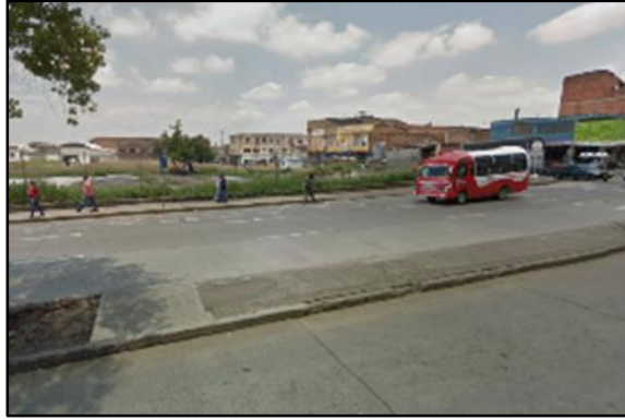
Foto 7. Demolición viviendas barrio el Calvario, carrera 10 entre calle 13 y 12. Registro recolectado en campo
