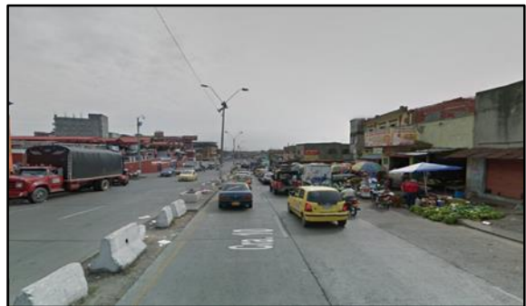
Foto 4. Barrio el Calvario, carrera 10 entre calle 13 y 13A. Google Maps, Street View 2015
