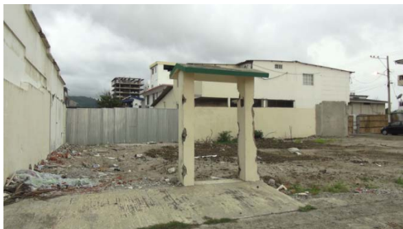
Figura 3.2.1.1. Restos de edificio Fuente: Nicolás Schwarzberg, fotografía digital, 2016
