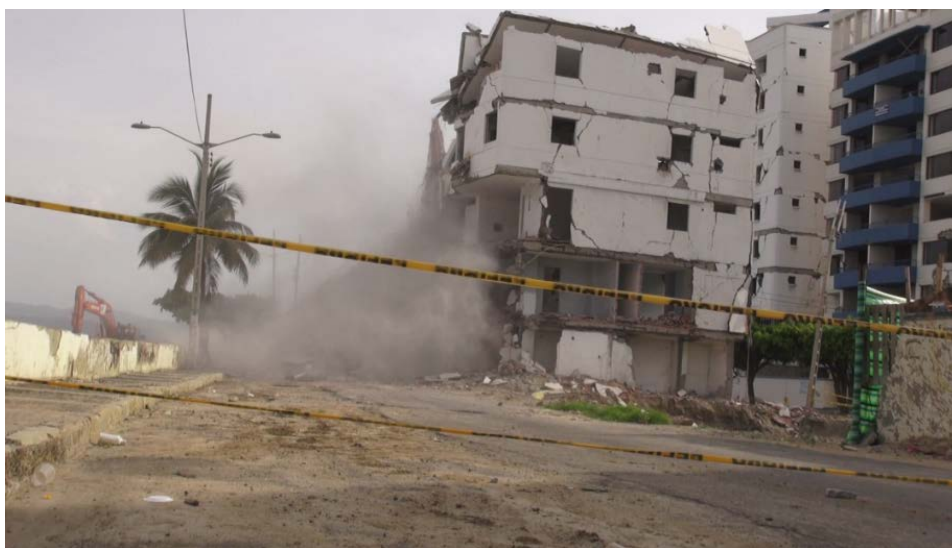
Figura 3.2.1.3. Demoliciones en el malecón Fuente: Nicolás Schvarzberg, fotografía digital, 2016
