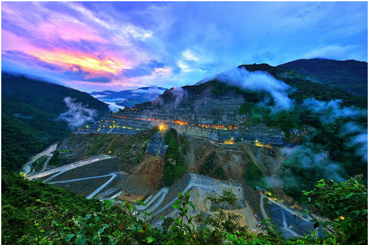
Foto 4.4.1. Construcción de la represa HidroItuango. Fuente: HidroItuango 2017
