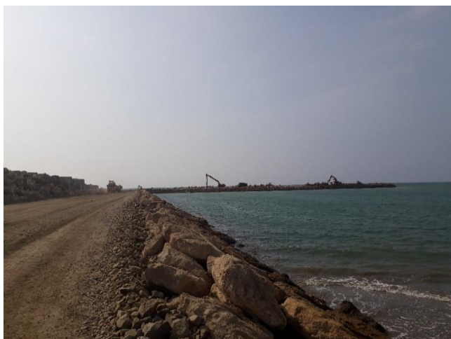
Ilustración 10 Foto 1. Puerto pesquero de Crucita en construcción Fuente: Trabajo de investigación
