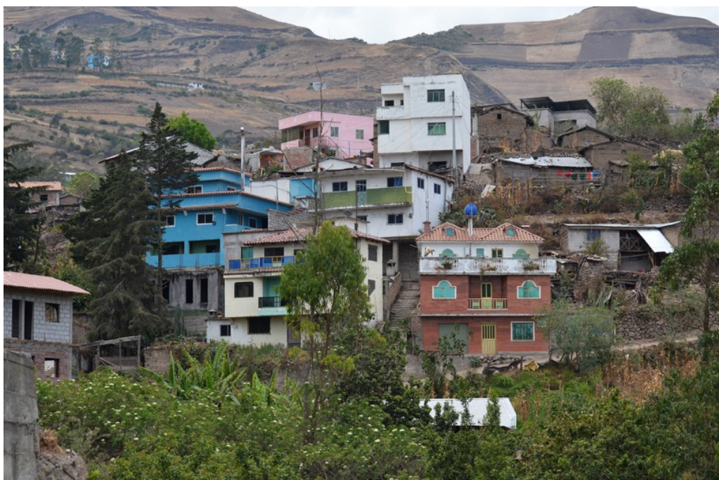
Figura 3. Nuevas construcciones en la comunidad de Nizag. Fuente: Mónica Cajo, agosto de 2018.
