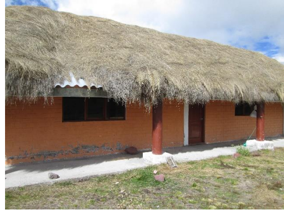
Figura 5.12. Infraestructura para el apoyo al guardabosques y uso para actividades turísticas
