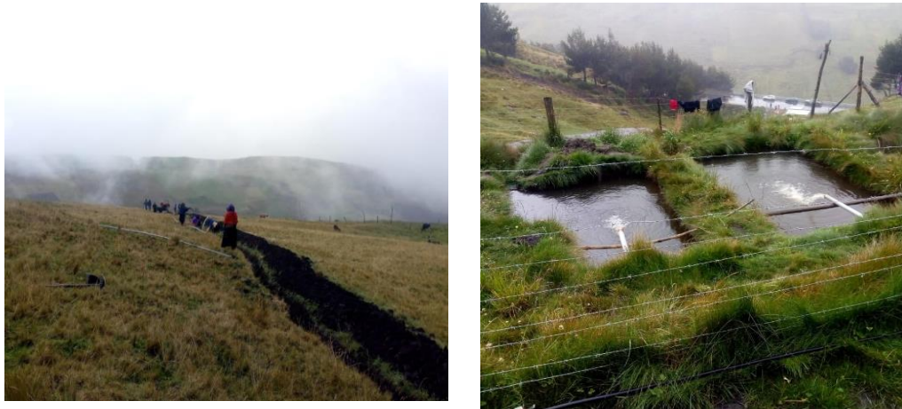
Figuras 5.6 Y 5.7. Proyectos ejecutados por la Junta de Agua en los sectores altos Fuente: Trabajo de campo 2019
