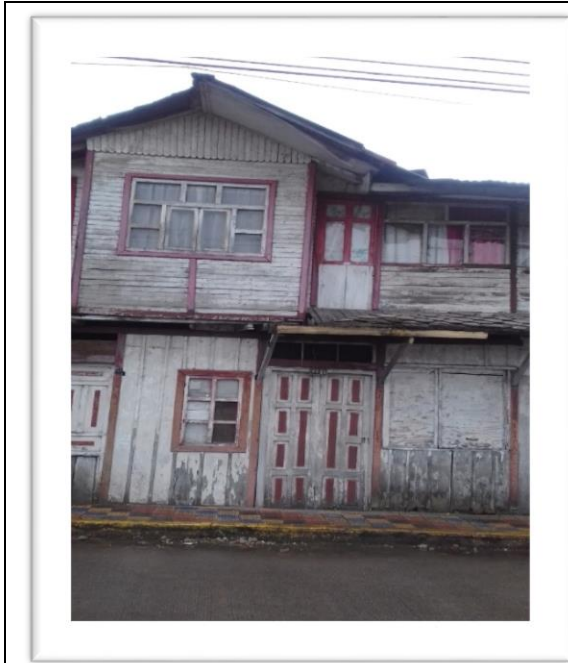
Fotografía 34: Viviendas en Shell
