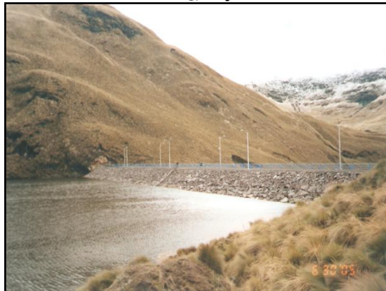
Fotografía No. 3.25 Presa Salve Faccha EMAAP-Q, Oyacachi
