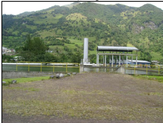
Fotografía No. 3.24 Estación Elevadora EMAAP-Q, Papallacta
