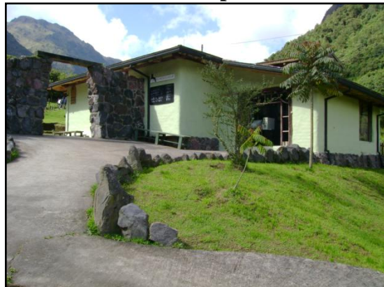
Fotografía No. 3.27 Instalaciones de Termas de Papallacta
