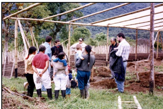
Fotografía No. 4.8 Construcción de Invernaderos
