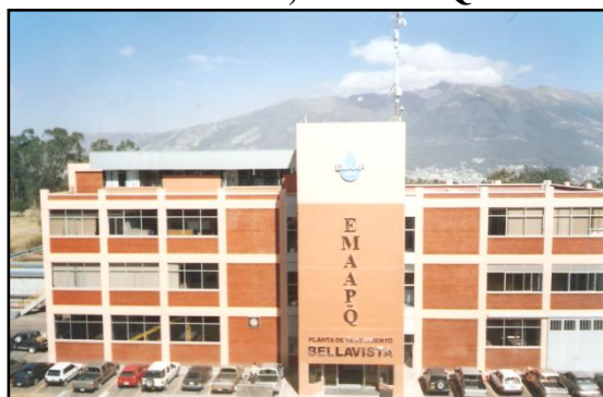
Fotografía No. 4.3 Planta de Tratamiento Bellavista, EMAAP-Q
