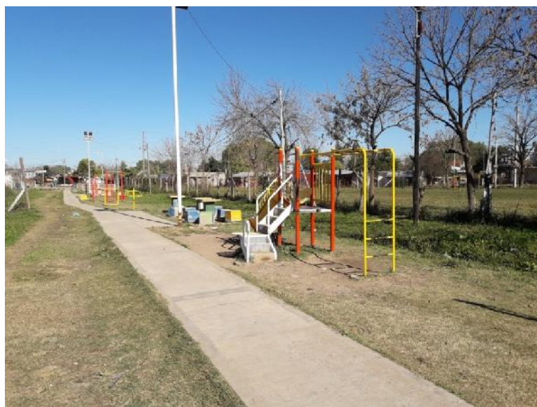
Ilustración 17. Fotografía del estado de la obra del proyecto “Corredor Aeróbico Caminos Inclusivos ”, tomadas el 24/05/2019
