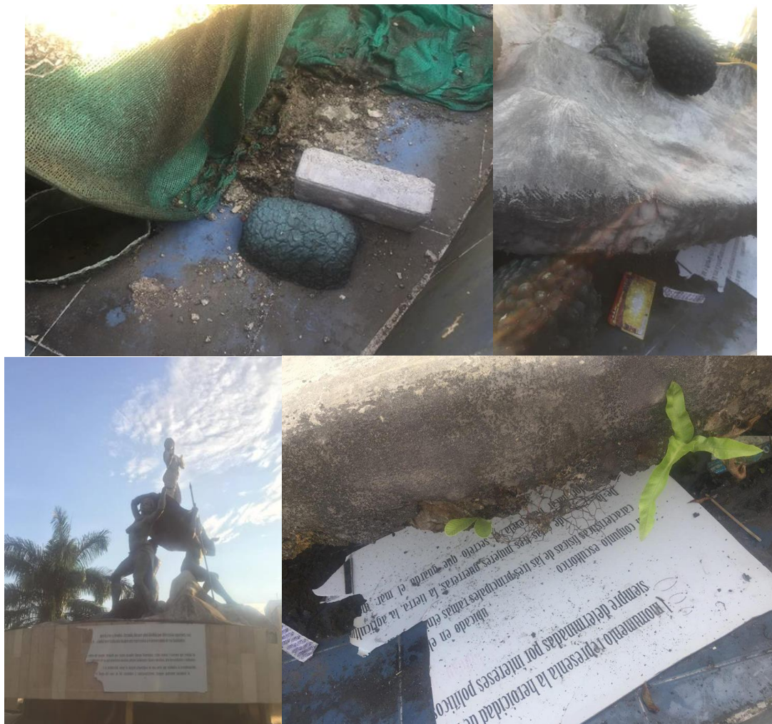
Figura 2.5. Imágenes del deterioro del monumento Fuente: Registro Fotográfico realizado por el autor en 2017.
