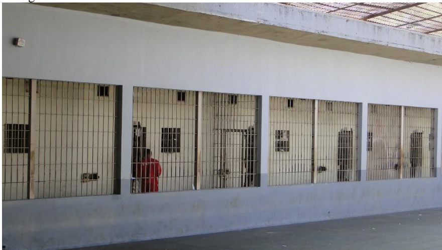
Fotografia 11 - Vista do corredor do bloco de celas
