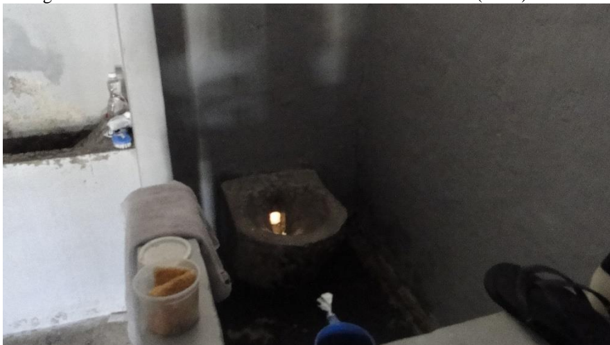
Fotografia 16 - Interior de uma cela - detalhe do vaso sanitário ("boi")
