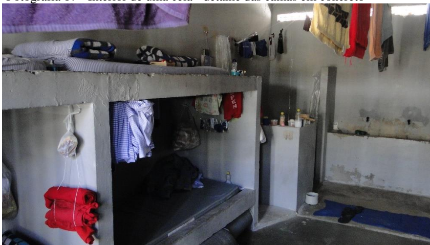
Fotografia 17 - Interior de uma cela - detalhe das camas em concreto
