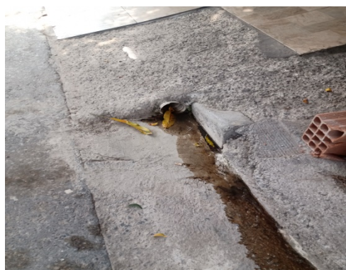
Figura 9: Rede de esgoto
