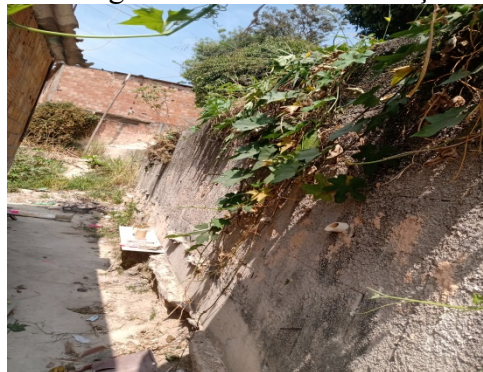
Figura 8: Muro de Contenção
