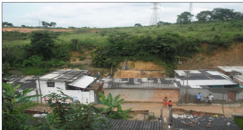
Figura 6: Vila Funcionários antes das obras
