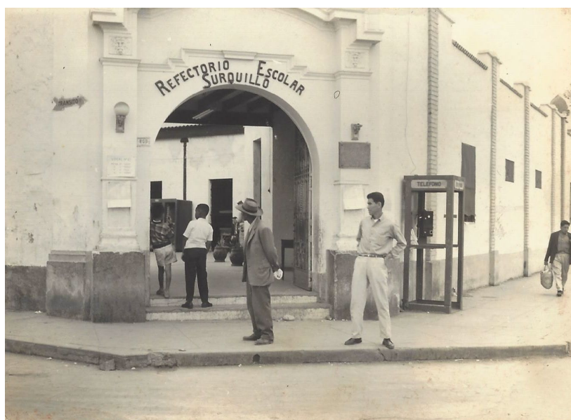
Figura 4.3. Refectorio escolar de Surquillo, Lima (1965)
