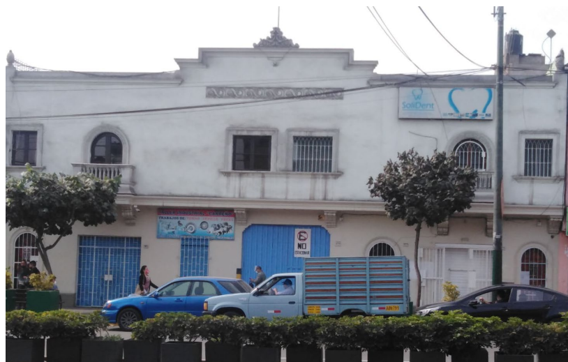
Figura 4.11. Antiguo chalet ocupado en su planta baja por tiendas de repuestos Fuente: Vega Slee, Johnatan; 2020
