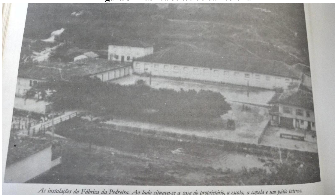
Figura 3 - Fábrica de tecido da Pedreira
