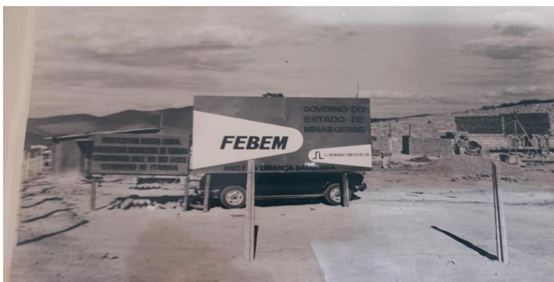
Figura 6 - Construção da sede da Febem
