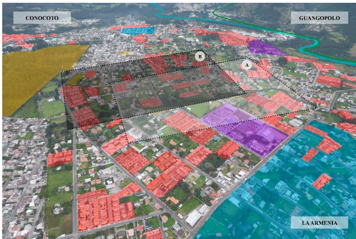
Figura 4.7. Aerofotografía de conjuntos habitacionales en La Armenia (1)
