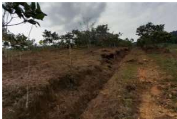
Fotografía 5.2. Vía terciaria en la vereda San Pablo. Fuente: Trabajo de campo
