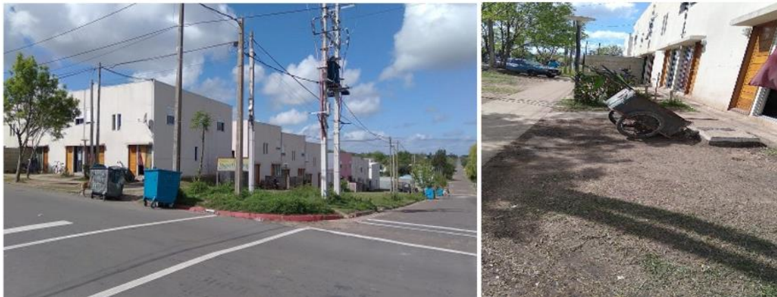
Figura 13. Viviendas del barrio Nuevo Horizonte en las que se observan servicios de veredas, residuos y alumbrado
