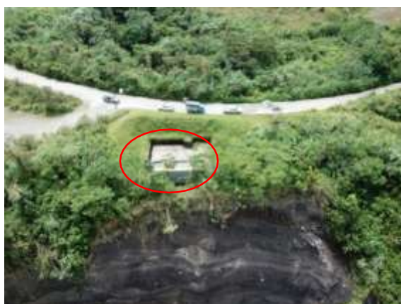
Foto 4.13 Vía al Puente a “Ventana 2”, 01 junio 2021, B. San Luis.
