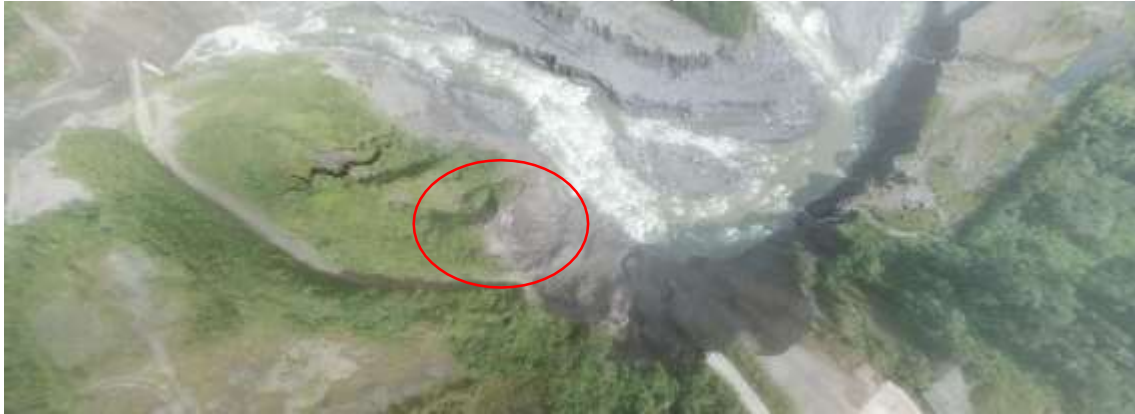
Foto 4.14 Vía al Puente a “Ventana 2”, 01 julio 1 2021, B. San Luis.
