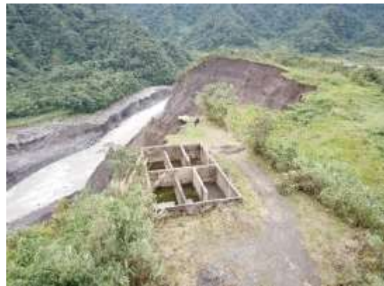
Foto 4.2 Tanques de agua, abril de 2021, B. San Luis.
