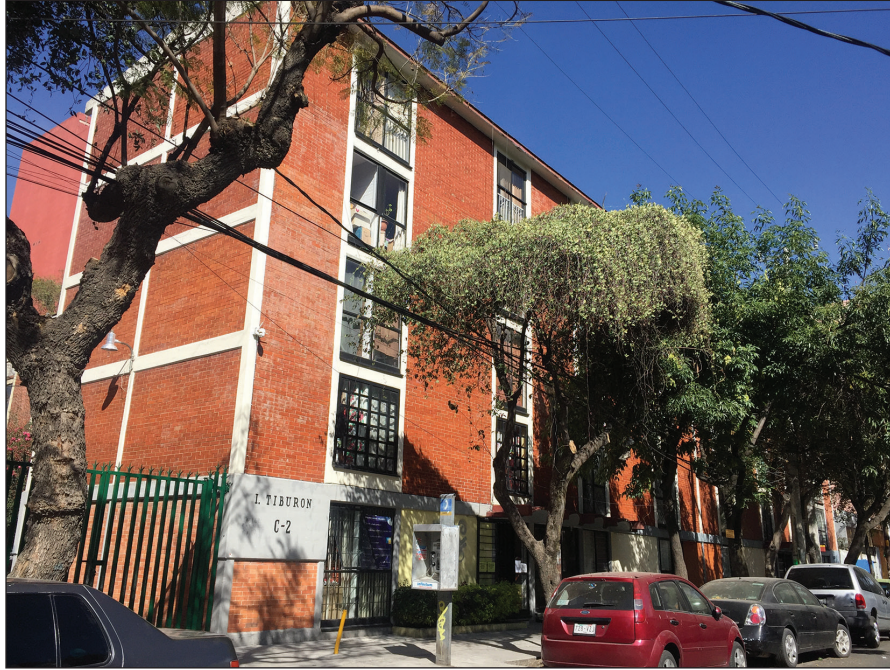
Figura 4. Edificio de altura media
