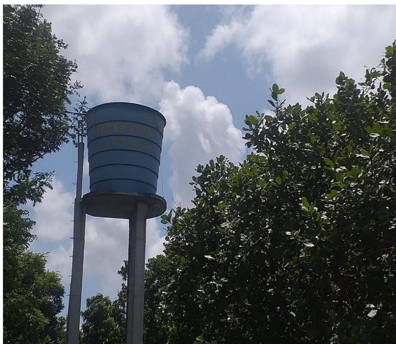
Figura 14 – Caixa d'água do assentamento
