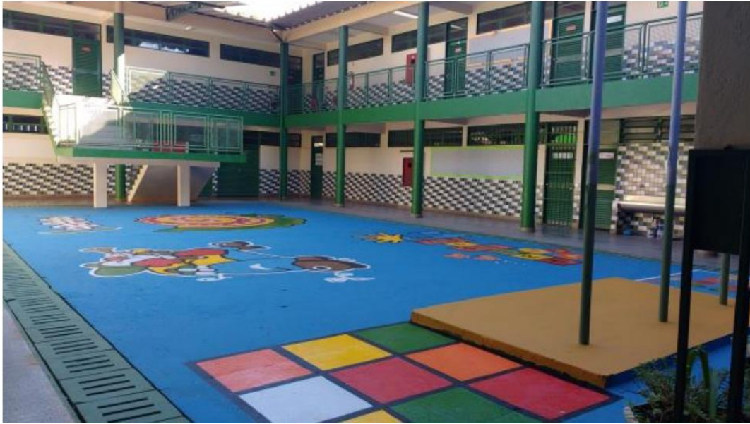
Foto 8 - ESCOLA CLASSE 325 DE SAMAMBAIA
