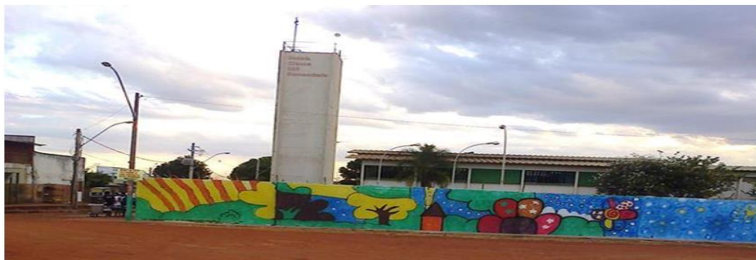
Foto 7 - ESCOLA CLASSE 325 DE SAMAMBAIA
