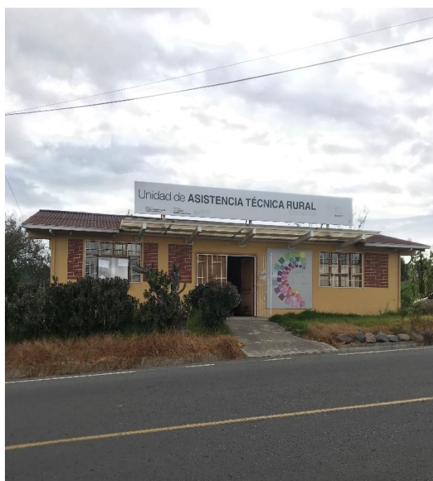
Imagen 17: Instalación de UATR en el cantón Cevallos
