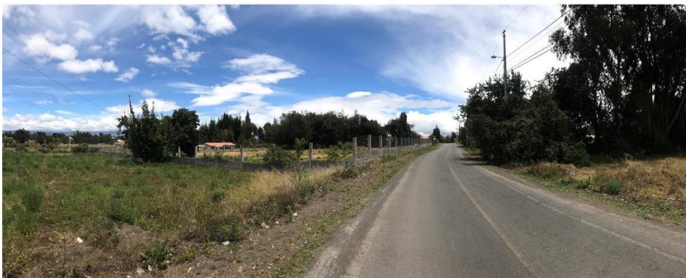
Tala de árboles para colocar cerramiento de bloques en El Tambo
