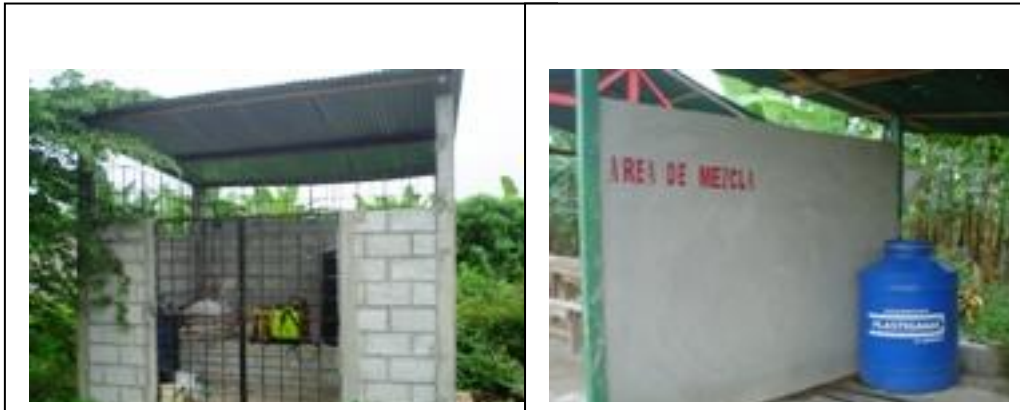
Imagen 19 y 20.- La construcción de bodegas para el almacenamiento seguro de agroquímicos según criterios Global GAP. También la construcción de zonas específicas para la preparación de agroquímicos y evitar riesgos de derrame.
